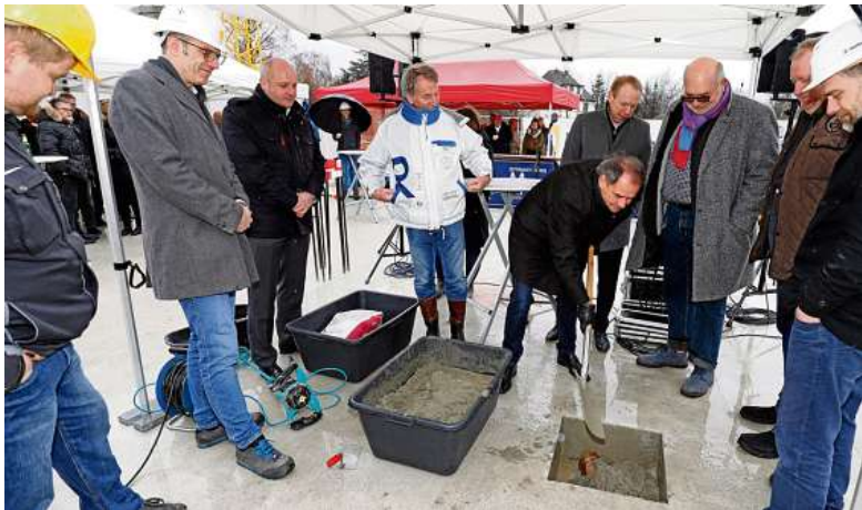
Partner, Verantwortliche, Oberbürgermeister und Bauherr bei der Grundsteinlegung auf dem Gelände der früheren Roselies-Kaserne.
