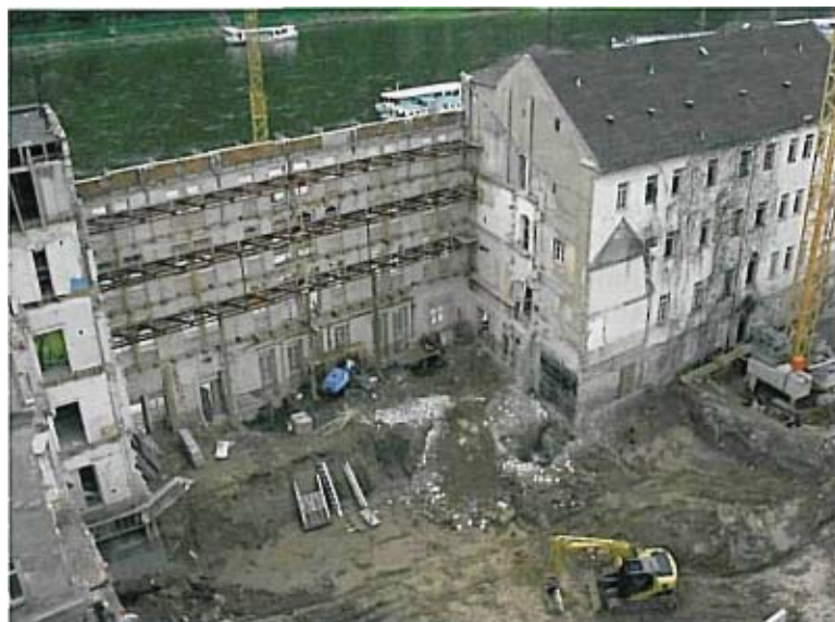
Bild 9. Aussteifung der elbseitigen Fassade mit Fachwerkträgern
