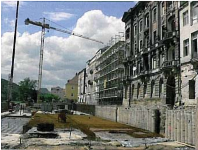
Bild 3. Baugrube der Tiefgarage mit Bohrpfahlwand
