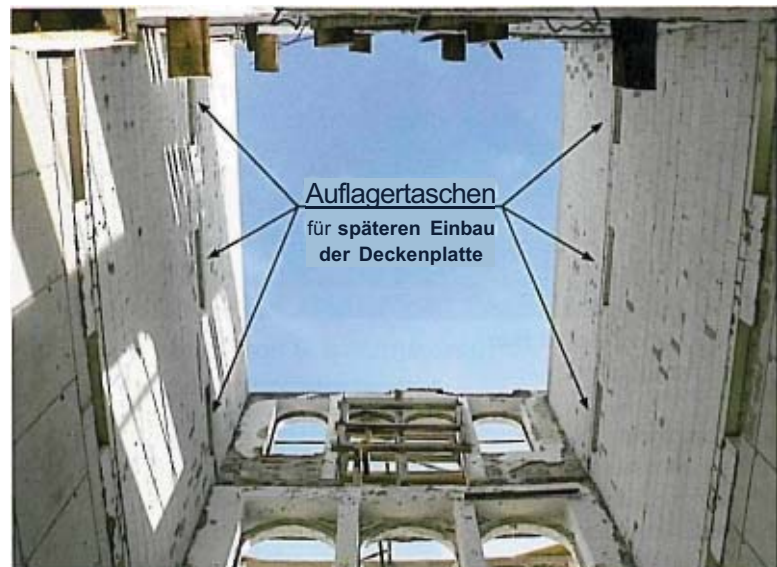
Bild 11. Durchbrüche in neu erstellten Querwänden für Auflagertaschen neuer Massivdecken
