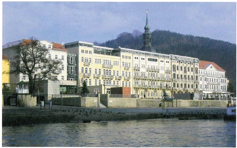
Bild 1. Elbseitige Ansicht des Hotels Elbresidenz
