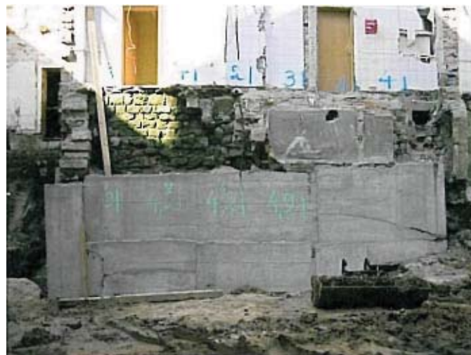
Bild 7. Unterfangung von Bestandsfundamenten
