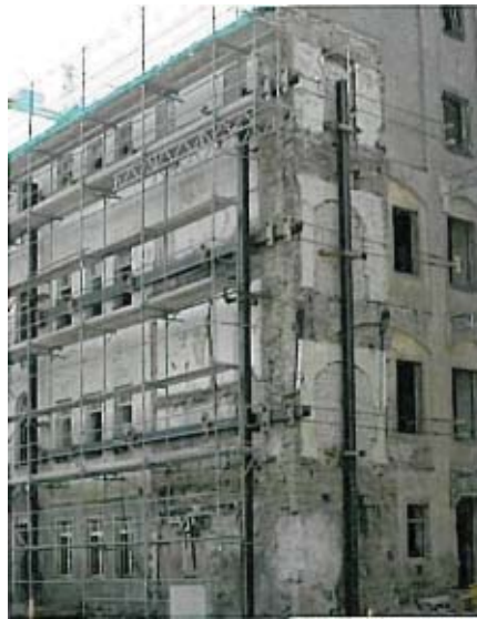
Bild 8. Fassadenaussteifung mit Stahlprofilen
