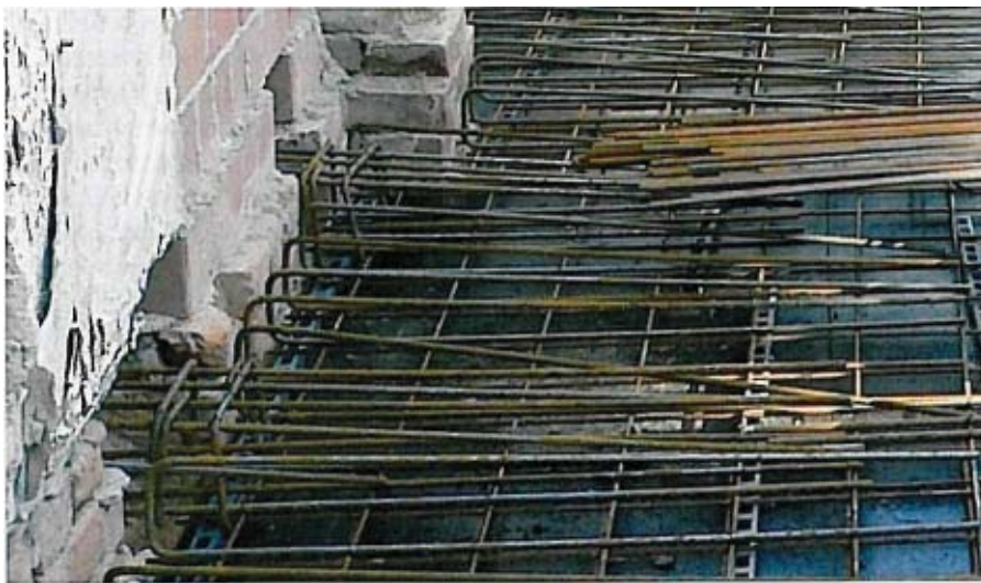
Bild 4. Einbau neuer Massivdecken mit Auflagerung in Mauerwerkstaschen
