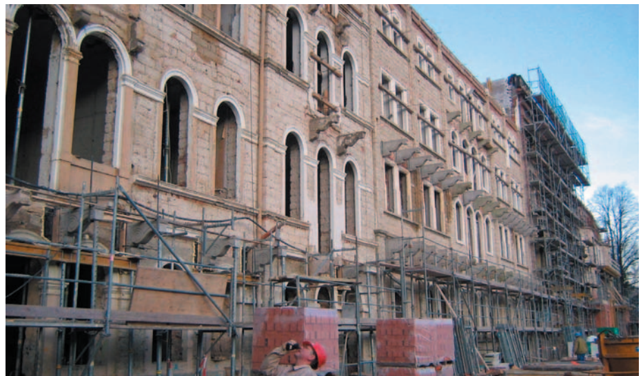
Bild 9: neue Stahlbeton-Balkonkonsolen nach dem Vorbild bestehender Sandstein-Konsolen
