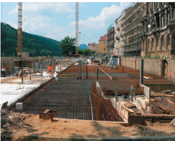
Bild 6: Baugrube der Tiefgarage mit Bohrpfehlwand
