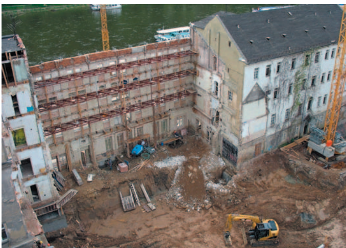
Bild 4: Aussteifung der elbseitigen Fassade mit Filigran-XV-Trägern
