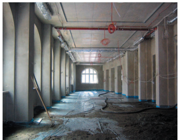
Bild 8: Erdgeschoss des Gebäudes Dampfschiff mit neu erstellten Durchbrüchen (rechts)
