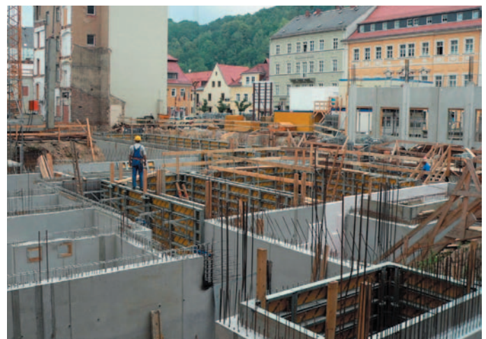
Bild 5: als weiße Wanne ausgebildetes Kellergeschoss der marktseitigen Neubauten
