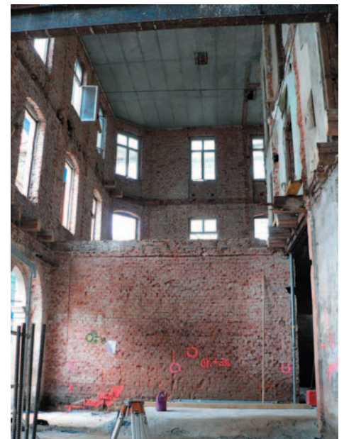
Bild 7: Austausch der Geschosdecken im Gebäude „Dampfschiff“
