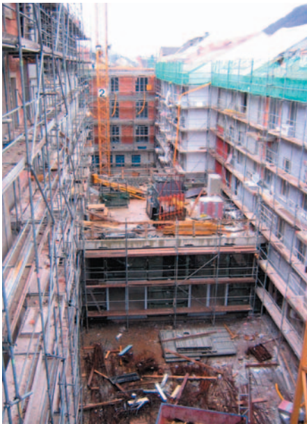
Bild 2: Neubau des Veranstaltungssaals im Inneren des Häuserblocks
