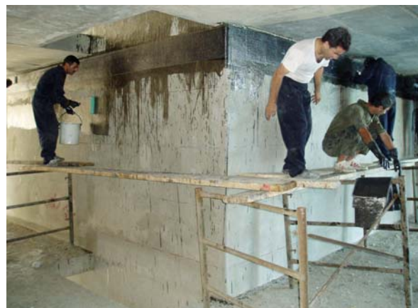
Bild 5: Schubverstärkung von Wänden mit Carbonfasern
