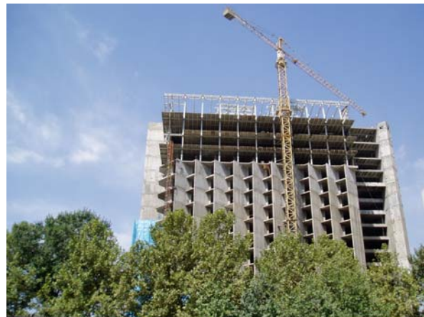
Bild 2: Aufstockung des Südturms
