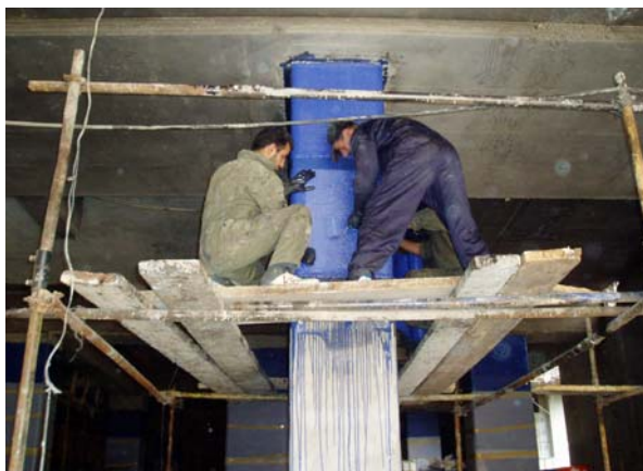
Bild 4: Umwicklung von Stützen mit Glasfasern
