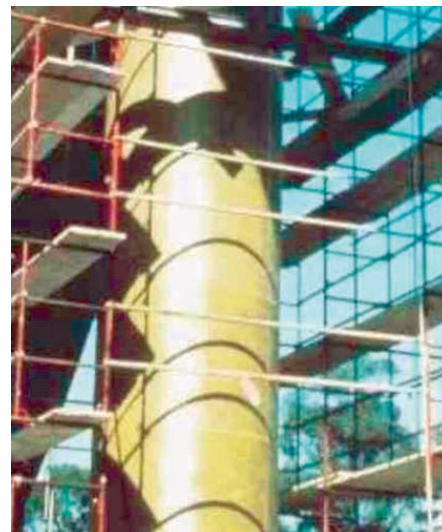
Abb. 13: Seismische Nachverstärkung mit Aramidfasern
