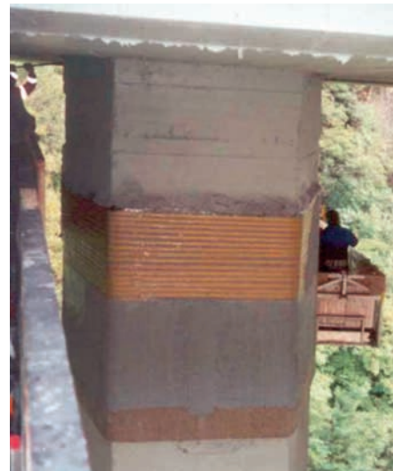
Abb. 10: Umschnürung eines Brückenpfeilers der Brennerautobahn mit vorgespannten Aramidbändern
