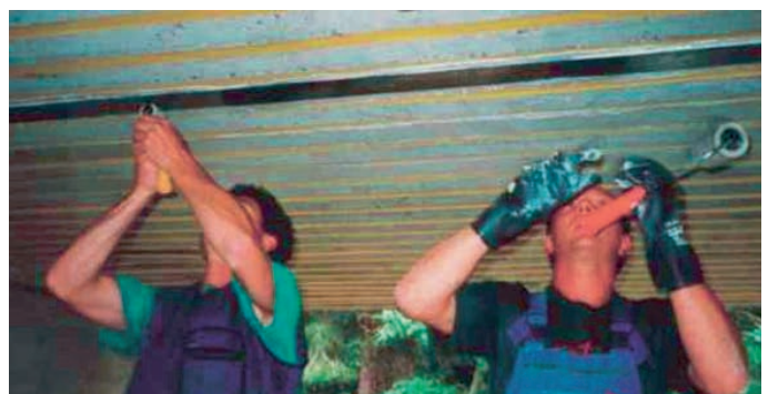
Abb. 3: CFK-Lamellen für die Biegezugverstärkung von Massivbrücken
