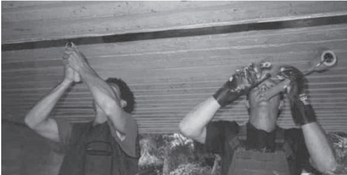
Bild 10.2: CFK-Lamellen für die Biegezugverstärkung von Massivbrücken
