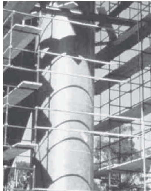
Bild 10.11: Brückenpfeiler nach starkem Erdbeben Bild 10.12: Seismische Nachverstärkung mit Aramidfasern
