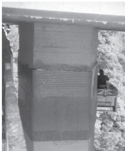
Bild 10.9: Umschnürung eines Brückenpfeilers der Brennerautobahn mit vorgespannten Aramidbändern
