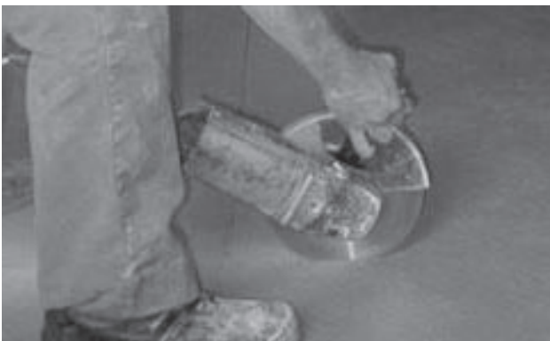
Bild 10.3: Einschlitzen der Betonoberfläche
