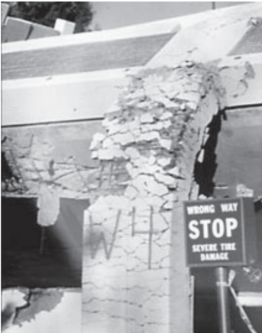
Bild 10.11: Brückenpfeiler nach starkem Erdbeben Bild 10.12: Seismische Nachverstärkung mit Aramidfasern
