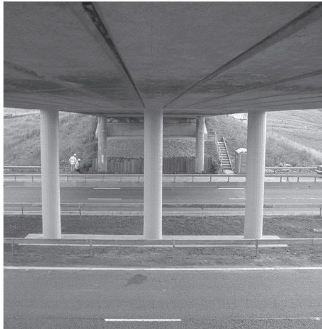
Bild 10.10: Umschnürung von Brückenfeilern mit FRP zur Verstärkung gegen Anpralllasten
