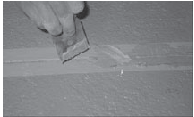
Bild 10.4: Auftragen des Klebers
