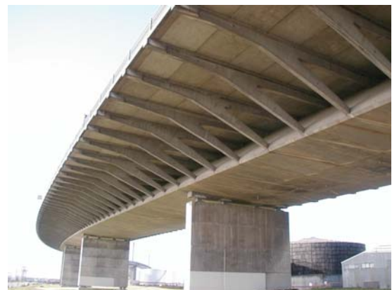
Bild 4 Untersicht des Hohlkastenquerschnitts mit auskragenden Querträgern
