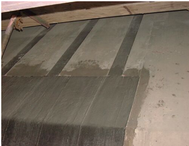
Bild 15 Verankerung der CFK-Lamellen mit CF-Laminaten (Seitenwände)
